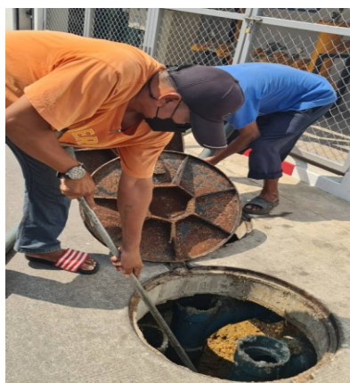
สูบลากตะกอนจากระบบบำบัดน้ำเสีย
